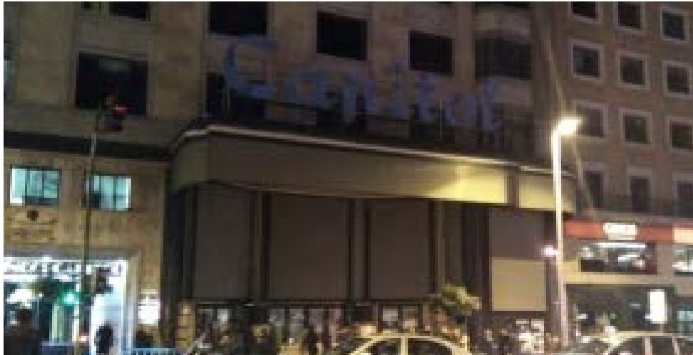
Fig. 1 — Variaciones en el edificio Carrion en función del contenido proyectado en las pantallas de los Cines Callao (intersección de la Gran Vía con la Plaza del Callao, Madrid, España), 17 de Noviembre de 2017. Fuente: J. García Carrizo.
