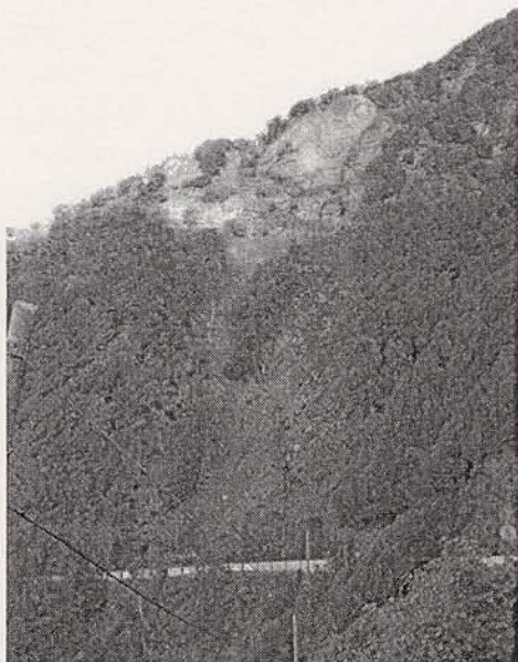
Fig. 1: Corredor abierto en la foresta por el deslizamiento traslacional de un bloque caído desde el escarpe rocoso de El Bailadero (Tenerife) el 16 de Noviembre de 2009.
