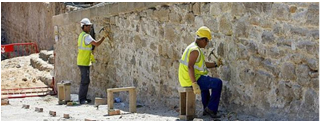
Figs. 7, 8 y 9. Trabajos de rehabilitación del Monumento a las Cortes de Cádiz, trabajos de restauración de cañones y reparación de paños de muralla.
