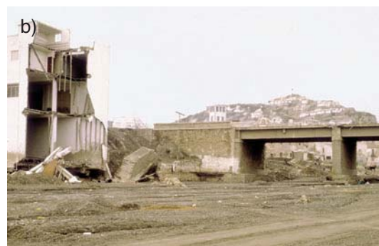
Fig. 9.- (a) Aspecto inofensivo de la rambla de Nogalte poco después de la riada de 1973 y (b) el amplio puente de Puerto Lumbreras, que quedó cegado por la avenida, y sus efectos en las construcciones situadas en los márgenes de la rambla.
