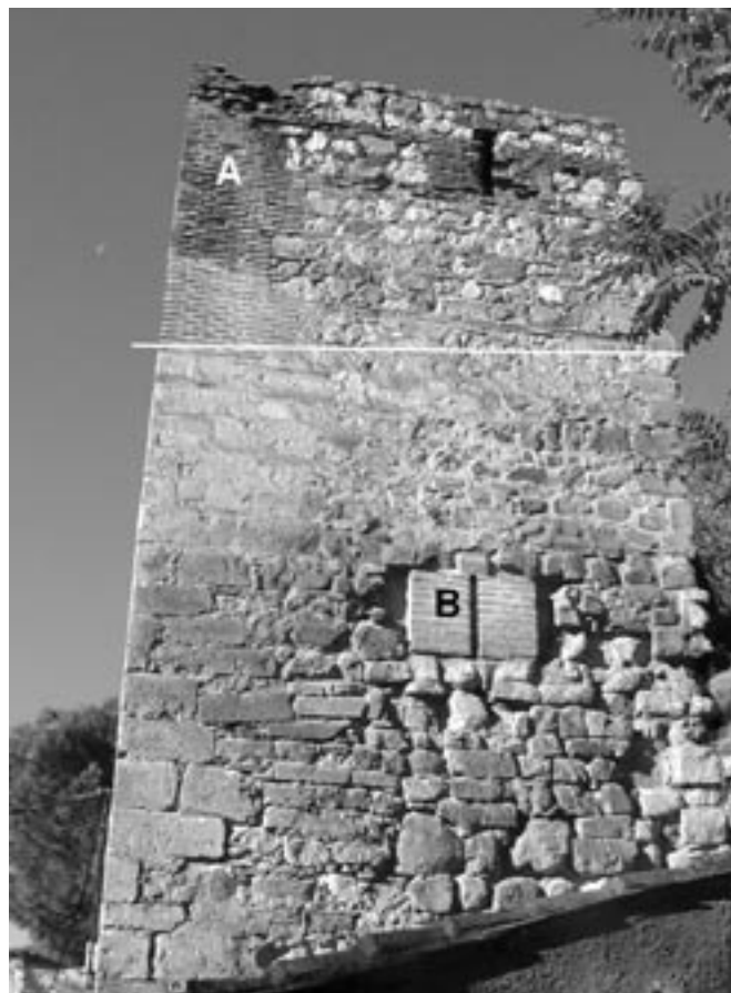
Fig. 5- Torreón (F1) donde la elevación de sus paramentos ha implicado la colocación de ladrillos de tipo III, durante el s.XIV. En las intervenciones de restauración llevadas a cabo durante el s.XX, se añadieron localmente ladrillos del tipo V (B).
