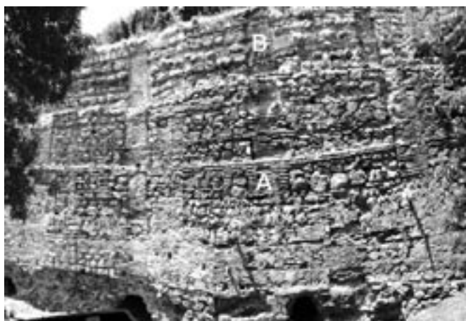
Fig. 4- Sector de la muralla (F2) que se encuentra en buen estado de conservación (s.XIII). En esta zona se identifican principalmente ladrillos del tipo II (A), aunque en la parte superior se reconoce el añadido de los ladrillos de tipo III (B) puestos en obra durante la fase de elevación en altura de la muralla (s.XIV).
