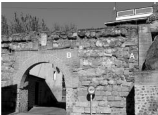
Fig. 1- Puerta de la Villa (s.XIII). Se encuentra muy restaurada con los ladrillos de tipo V (A), pero tiene zonas donde todavía existen ladrillos de tipo II (B).
