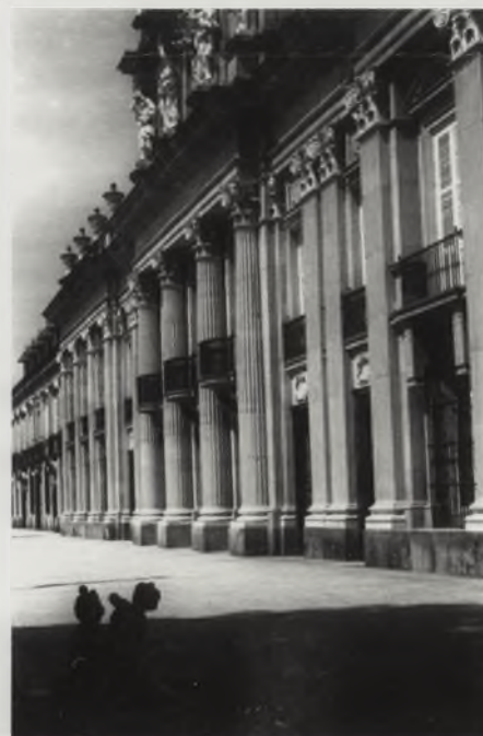
FIGURA 4. Fachada del Palacio Real de La Granja, donde las columnas están construidas con Caliza Rosa Sepúlveda.
