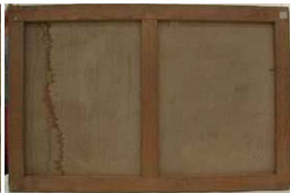
Fotografía inicial del reverso de la obra, muestra la tela y de la mancha de humedad.
