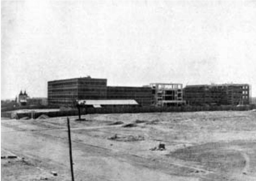
Estado de las obras el 17 de septiembre de 1933. Una cubierta provisional protege la entrada de los estudiantes al ala izquierda. Huarte y Cía. Dossier del edificio [1944]. Colección de Javier Ortega.
